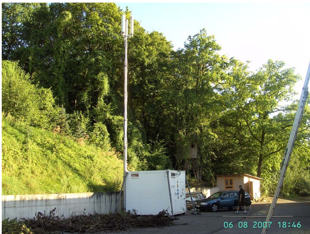
Abb. 33 Teststation in Weipoltshausen
