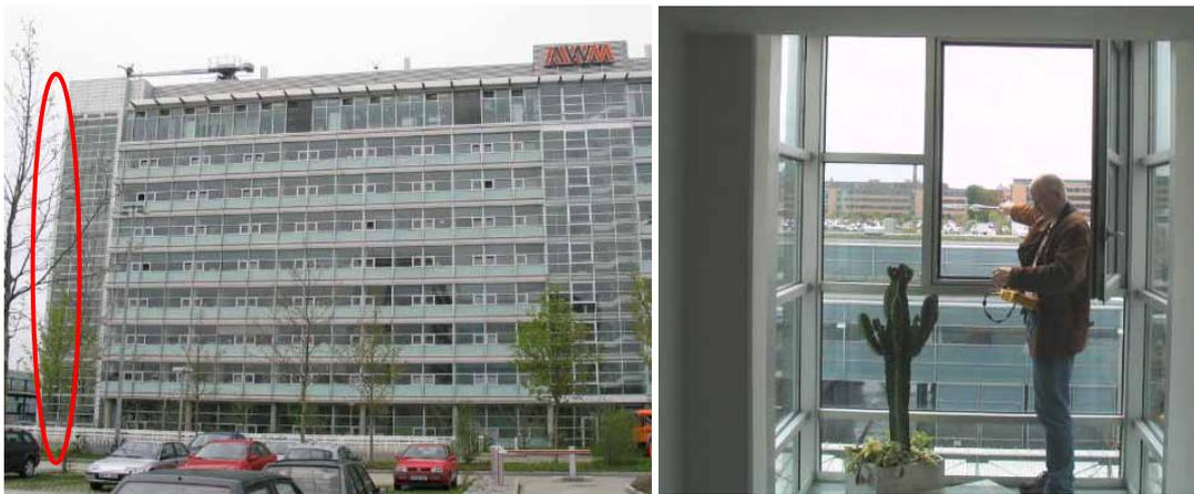
Bild III.2.29: Ostansicht von *Gebäude 3* mit den Messpunkten (links); Messung im südlichen Glasflügel außerhalb der Fenster (rechts)
