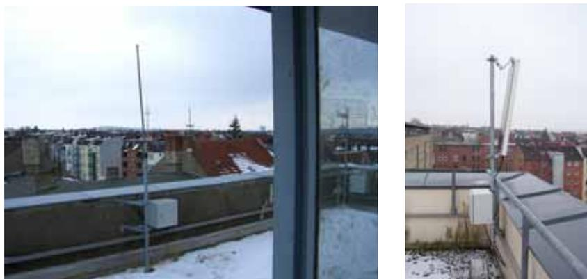
Abbildung 6-30: Access Point Antennen. Rundstrahler (linkes Bild – AP1) und Sektor Antenne (rechtes Bild – AP2).
