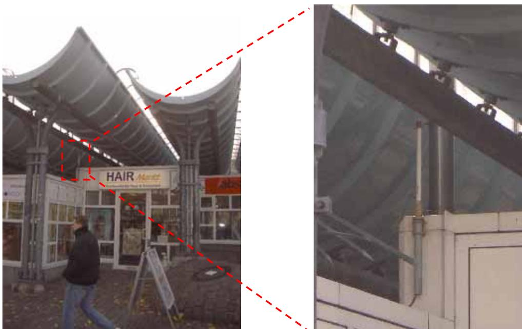
Abbildung 6-13: Access Point Antenne auf Geschäftslokal unter Dachkonstruktion, links: Gesamtansicht, rechts: Detail.
