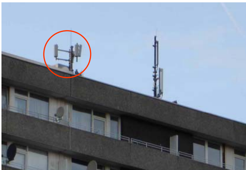
Bild 2.14 WiMAX-Anlage in Wuppertal, an der die Reproduzierbarkeitsmessungen durchgeführt wurden
